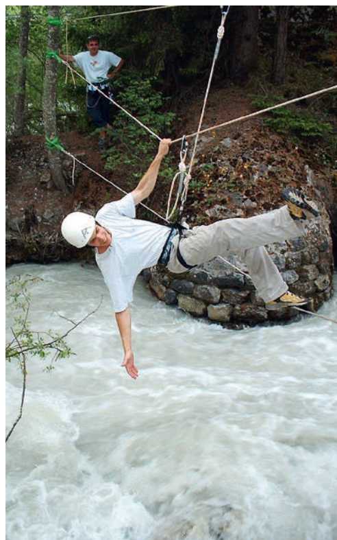
Gemeinsam eine Seilbrücke zu bauen (und zu testen!), ist in vielerlei Hinsicht aufregend.
